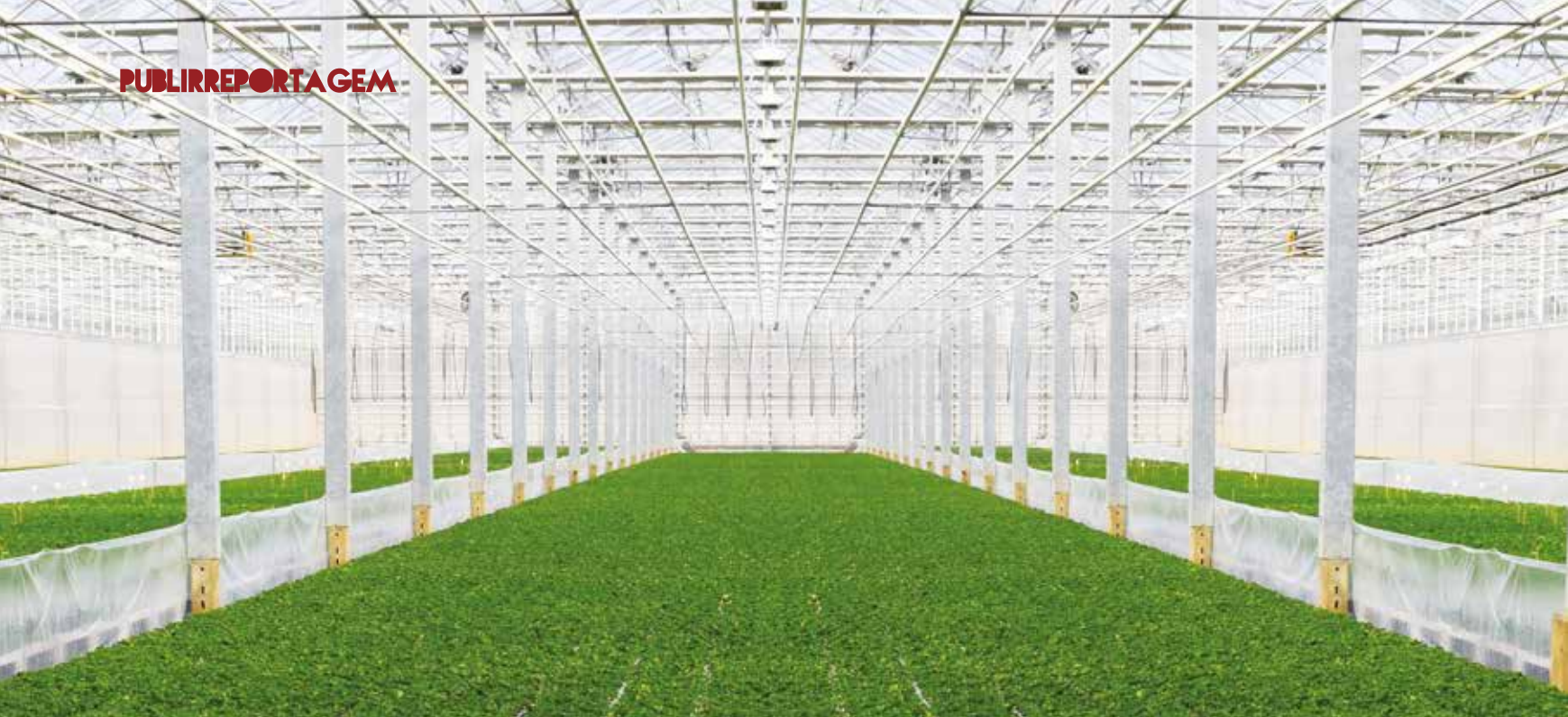
› Instalações do Grupo Padana, em Itália
